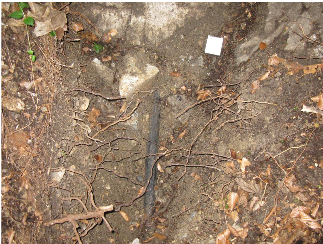
Foto 5: Betonový stabilizační prvek v sondě III nad původním potrubím (foto R. Novotný, červenec 2012).
